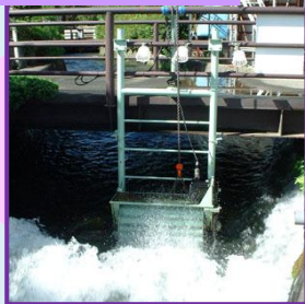
谷村工業高校東側の 急峻用発電機
