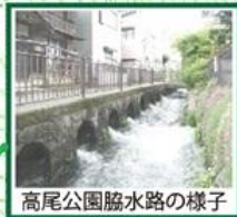
高尾公園脇水路の様子
