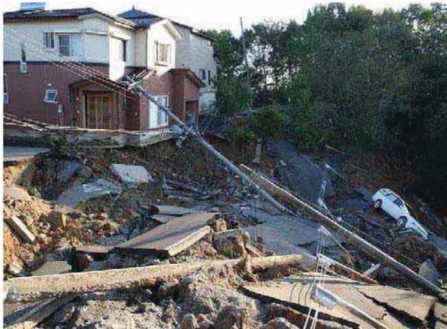
— 崩落した道路 —
