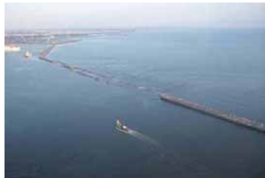
津波により破壊された防波堤
