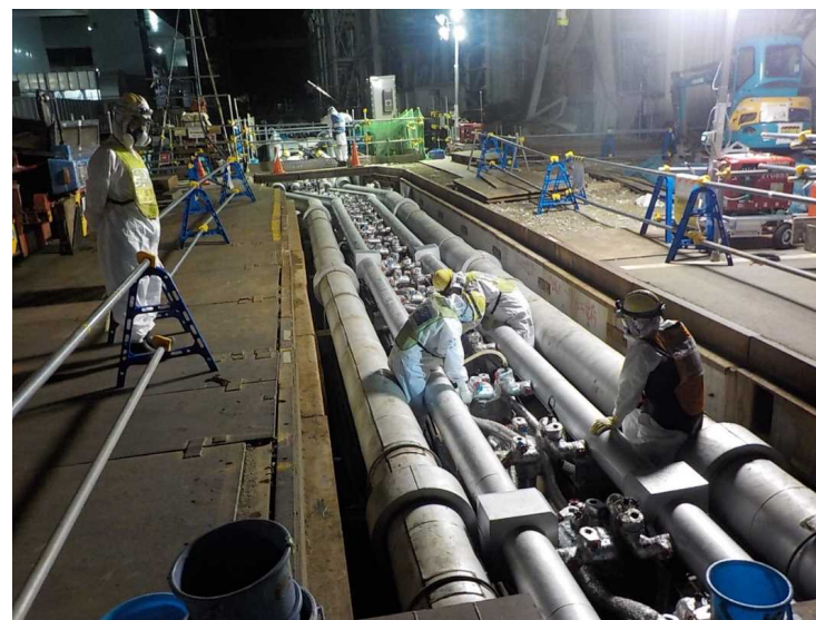
冷媒の移送管
