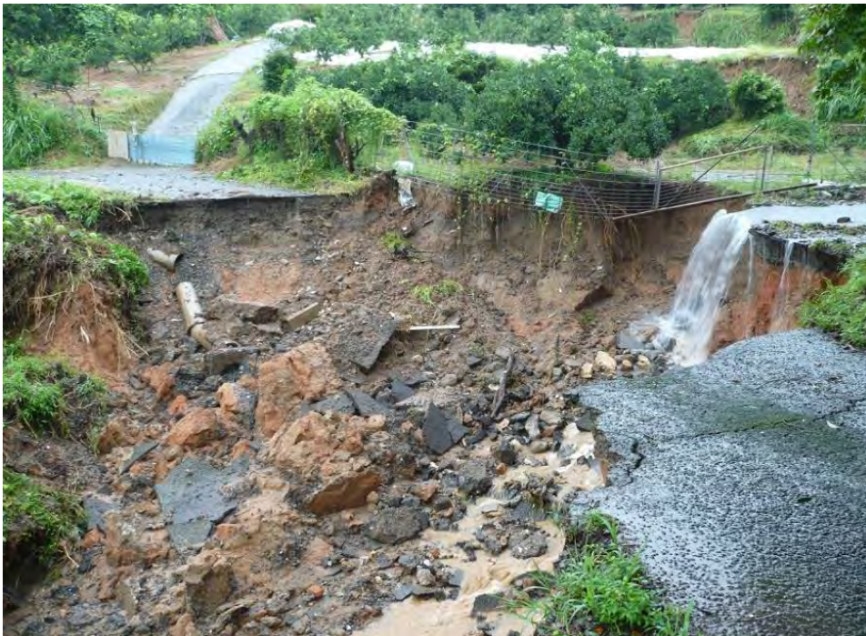
(小城市 道路崩落)
