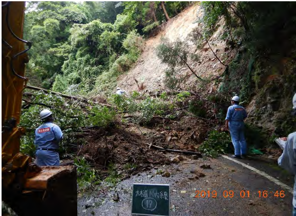
(小城市 道路への土砂流入)
