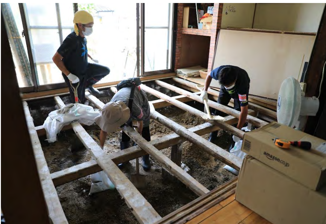
(武雄市 ボランティア等による浸水家屋片付け作業)
