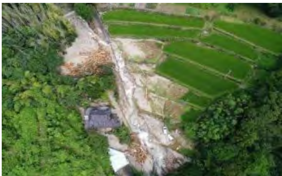
(佐賀市 水路被害)
