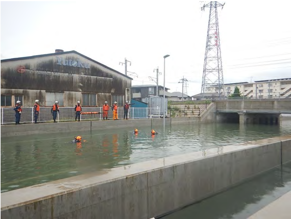
(佐賀市 高架下道路の冠水)
