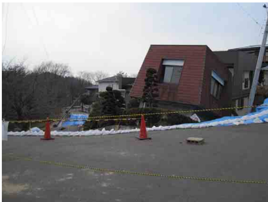
宅地と市道が同時に崩壊（福島市あさひ台団地：南側から撮影）
