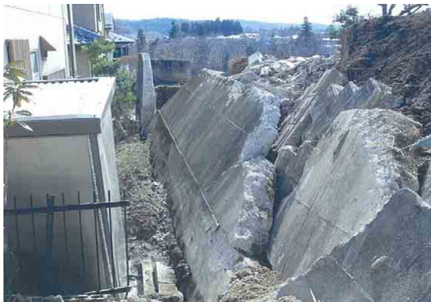
大規模な擁壁の破損倒壊（大搦目山地区）
