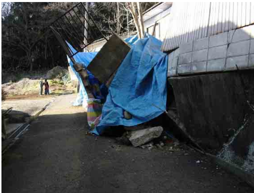
擁壁の崩壊（葉ノ木平地区）
