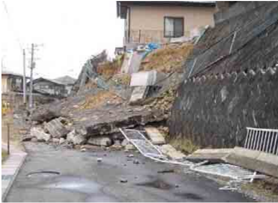
民地ブロック積擁壁崩壊（郡山市大槻町）
