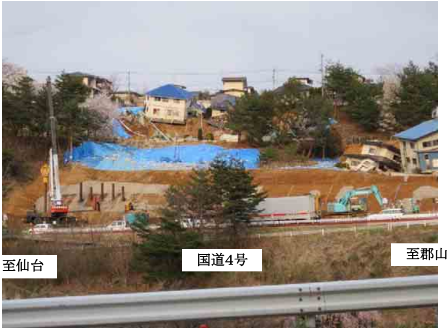
国道4号上り線側民間造成宅地の法面崩壊 (福島市あさひ台団地：全景写真)
