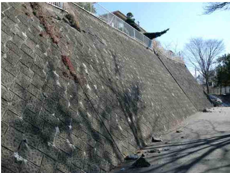
連担する宅地擁壁の被災（三本松山地区）
