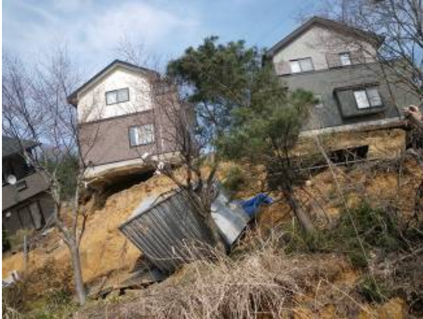
法面と宅地の崩壊（青葉区西花苑地区）
