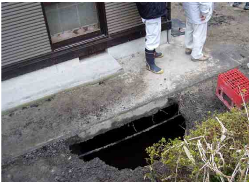
亜炭採掘に起因する宅地の陥没（若柳川南上堤地区）
