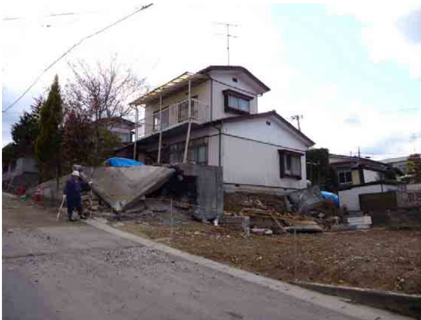
谷埋め型造成地の滑動（青葉区中山地区）
