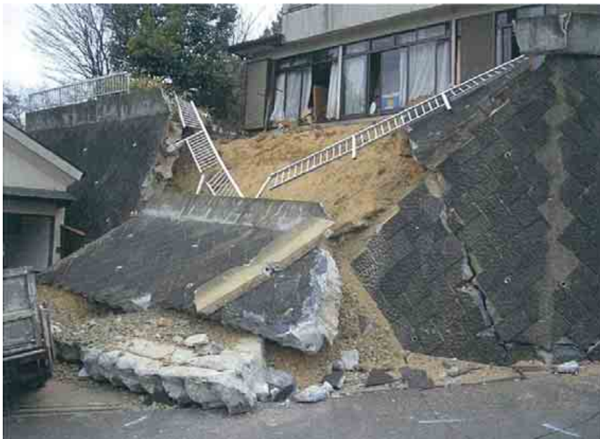
擁壁と宅地の崩壊（三本松地区）
