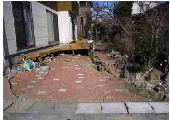
民地ブロック積擁壁崩壊（郡山市大槻町）
