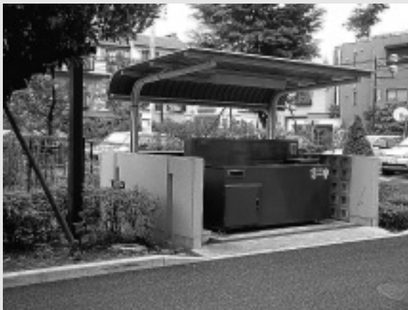
桜堤団地内の生ごみ処理機
