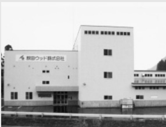
廃プラスチック利用新建材製造事業施設
