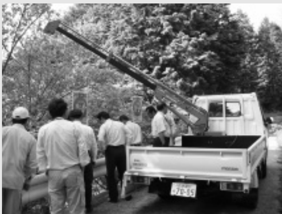
急斜面や深い谷に落とされた不法投棄物回収のため、小型クレーン付きのトラックを導入
