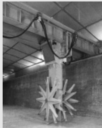
パドルにより散布された材料はソフトに堆積するため凝塊の生成を防ぎ、均一で良好な発酵が行われる
