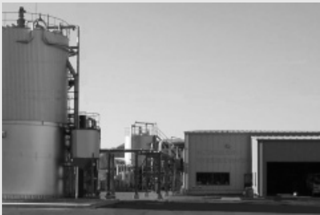
生ごみバイオガス化実証試験プラント（全景）
