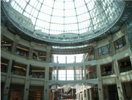
壱番街（再開発ビル）（三町ドーム）
