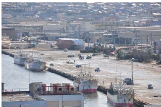
岸壁に漁船が乗り上げた様子
