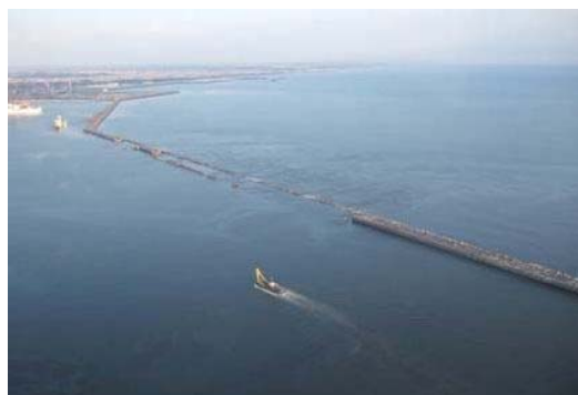
津波により破壊された防波堤
