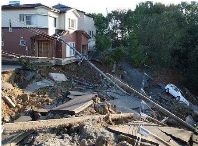
— 崩落した道路 —
