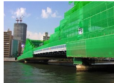
橋りょうの補修
