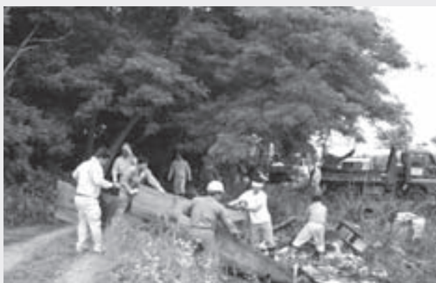
回収作業をする山形県建設業協会山形支部青年部ボランティアのみなさん
