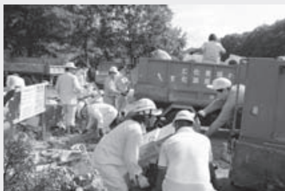
快適京田辺不法投棄撲滅計画により一斉撤去を行う職員
