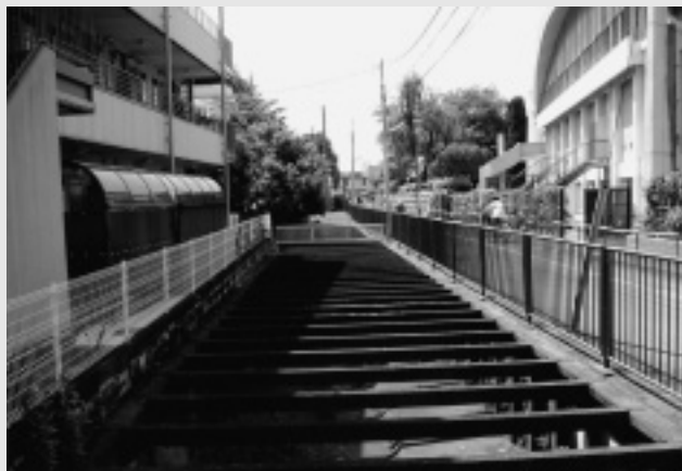
仙川の現況(コンクリート三面張の構造となっている)
