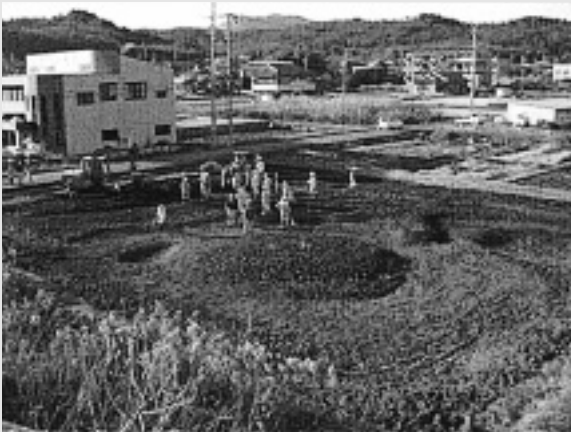
建設業界のボランティアグループ「建友会」による造成。 (この後、手作業によりビオトープづくりが、地域住民、造園業者、上下水道業者によって始められた。設計図は、環境市民団体が素案を作った)
